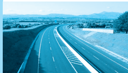
Строители изграждат автомагистрала.
