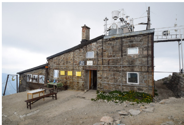
Fig. 2. La estación meteorológica de Musalá, cubierta de una red metálica
