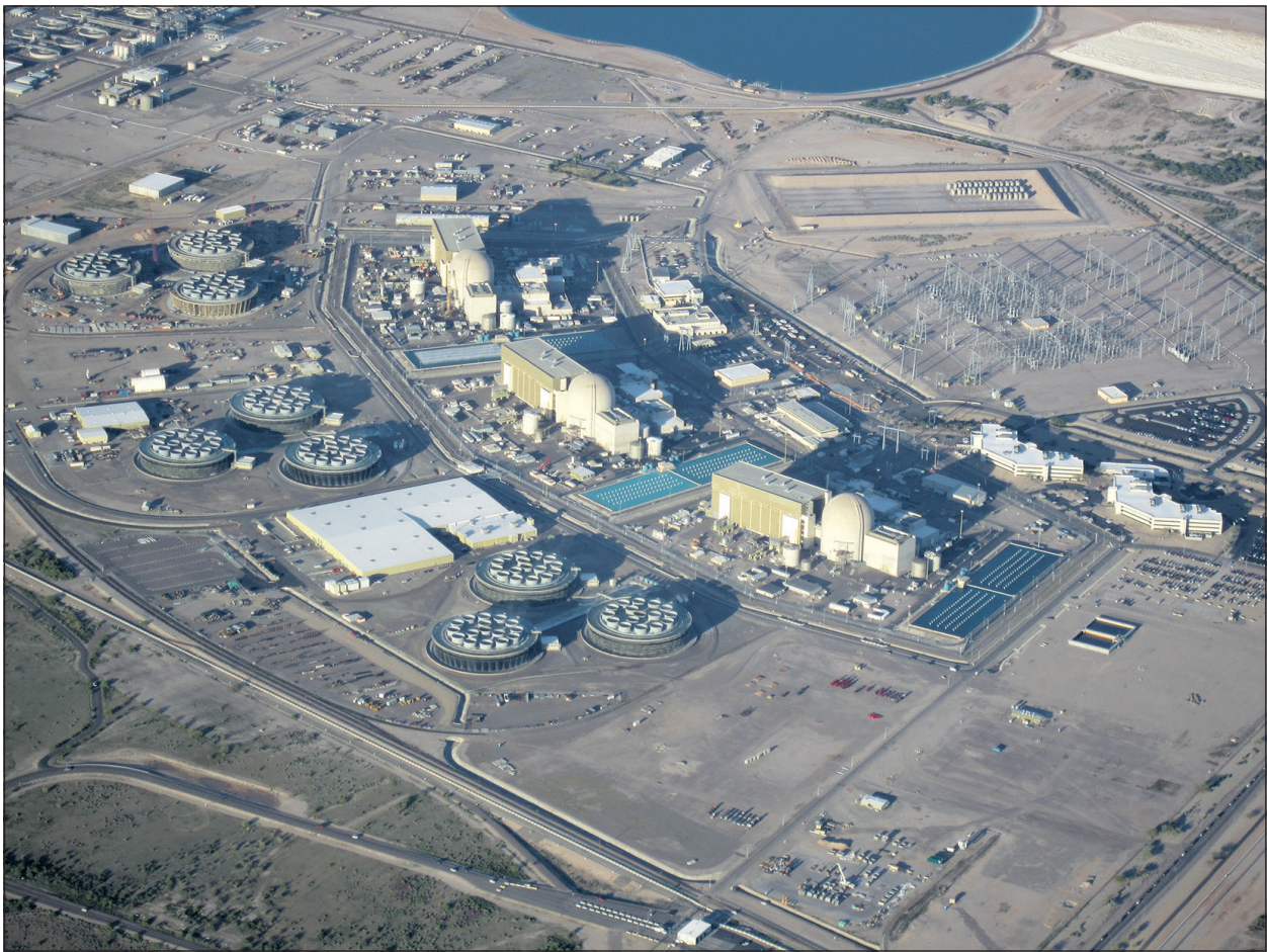
Centrale nucleare negli Stati Uniti – Palo verde
