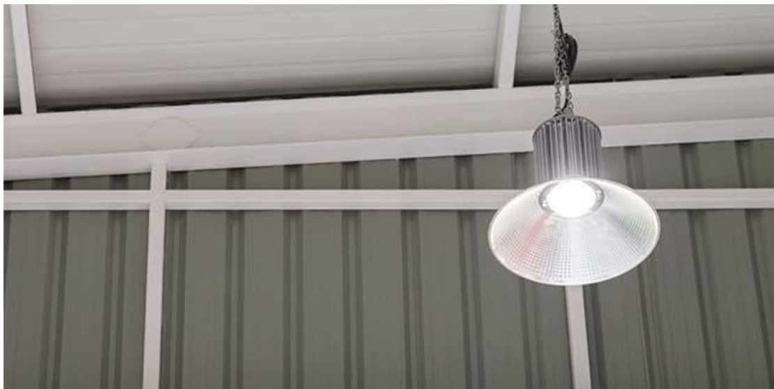
Фиг.24.4. Светодиодно тяло за промишлено осветление тип „ Камбана“ (57)
