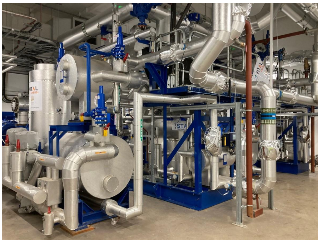
Фигура 9.7 Индустриална термопомпена система за централизирано отопление, работеща с амоняк (източник: АВВ – https://global.abb/group/en )
