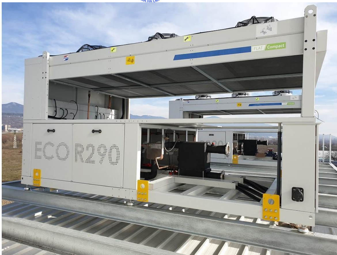
Фигура 9.2 Водоохлаждащ агрегат, работещ с R290
