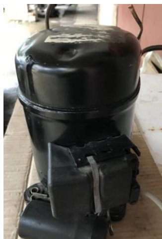
Фиг. 2.23. Херметичен фреонов компресор
