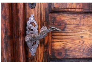
Постигане ефект на състаряване чрез орехов байц.
